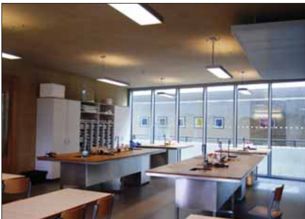
Bild 2. Energieeffizienz 1: Konstantlichtregulierung durch KNX in den Labors. Quelle: Andromeda
